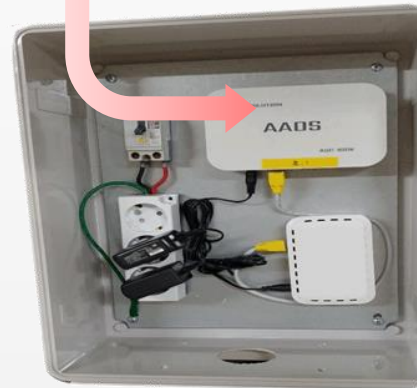
방수 함체 이용 전원 및 제어기 설치
